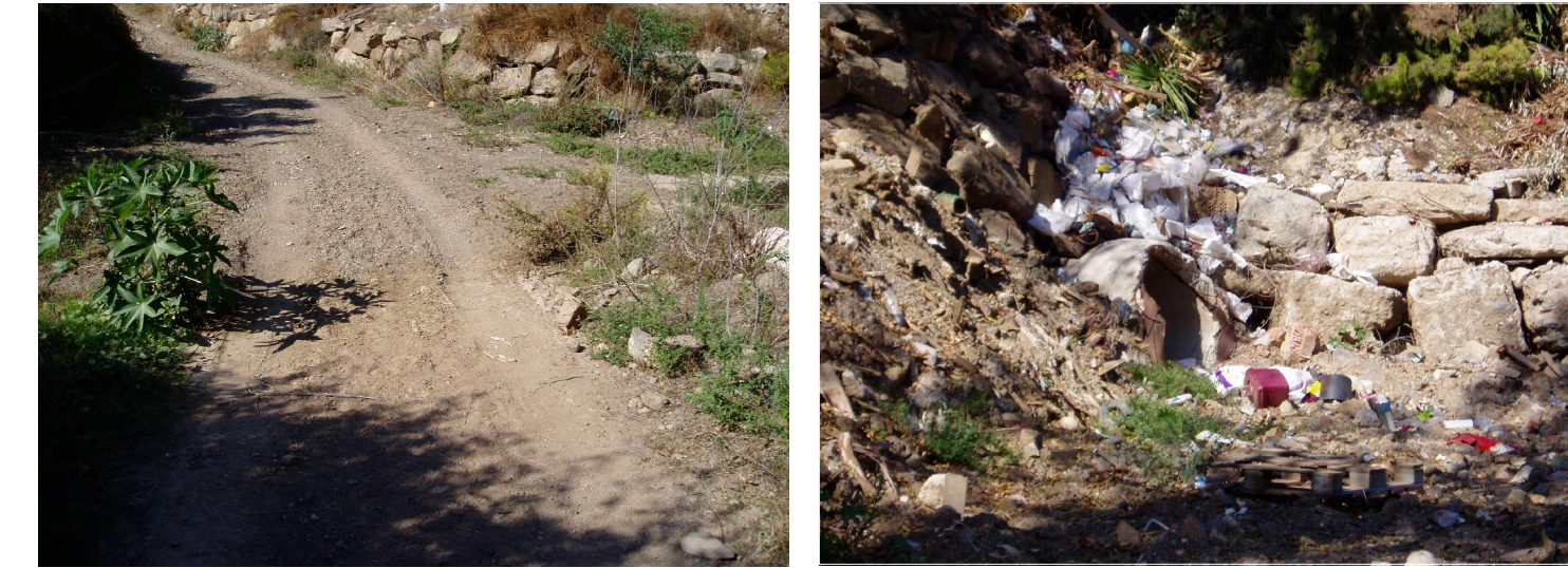
F3 Sección cauce aguas abajo
