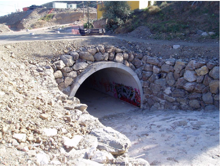
F1 Sección obra de drenaje aguas arriba
