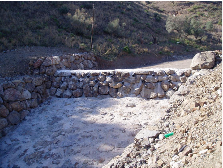
F2 Sección cauce aguas arriba
