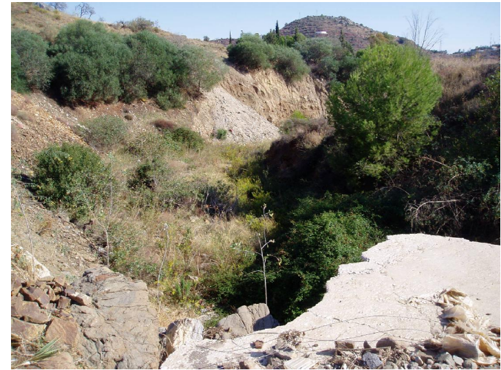
F3 Sección cauce aguas abajo
